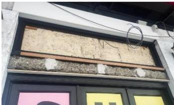
Lors d'un sondage récent effectué au niveau de la baie centrale, on a découvert la présence d'un linteau et d'un massif en béton obturant l'imposte. Également réalisés en infraction, ces travaux ont été réalisés à une date inconnue.
