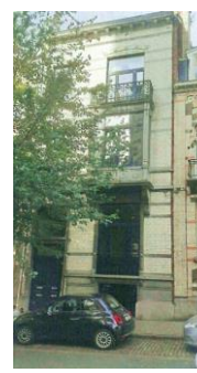
État existant de la façade (photo jointe à la demande)
