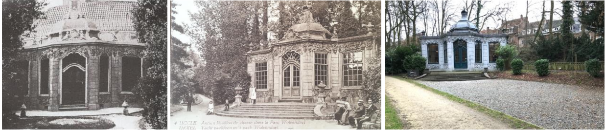
Configuration du pavillon à Amsterdam (1902, à gauche) et à Uccle (1910, au centre : photos issues de l'article « Le Parc de Wolvendael, de 1700 à nos jours »), situation actuelle (photo de droite jointe à la demande)
