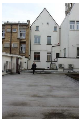
Façade arrière de la maison 5 Grand-Place
