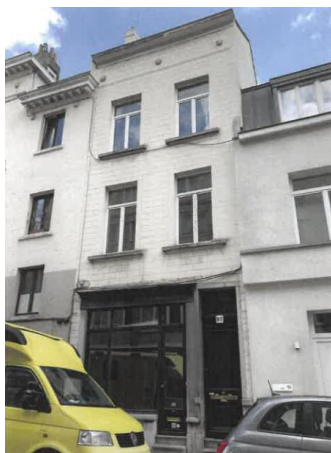
Photo actuelle de la façade
