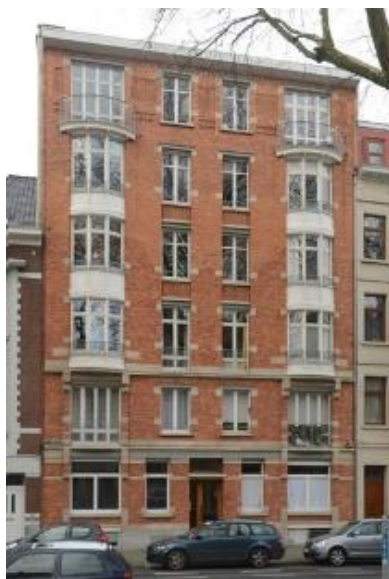
Photo de la façade avant. Google Street View©
