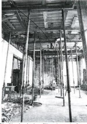
Démolition des planchers d'étage et reconstruction en éléments préfabriqués, 1996 © Pierre Hansert
