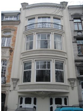
Photographie de la façade du n°36, extraite du dossier de demande.
