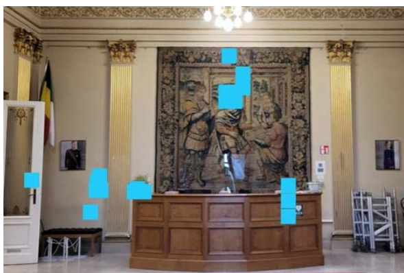
Emplacements des analyses stratigraphiques sur le mur sud de la salle des pas perdus (Document extrait du dossier de demande).
