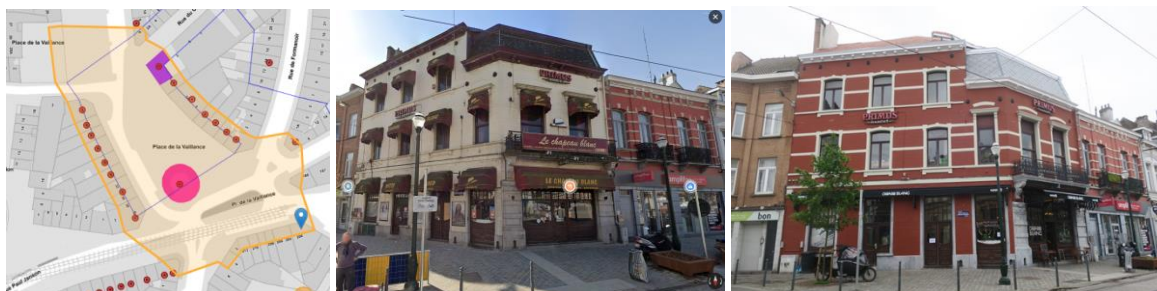
Extrait Brugis, situation avant (extrait du dossier) et après travaux (photo CRMS, mai 2024)
