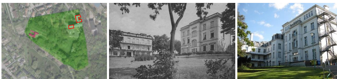
Localisation du projet avec indication du château et de l'aile hospitalière (© Brugis) Aile hospitalière à gauche et château à droite : état vers 1950 et situation avant travaux (photos extraites de la demande de permis unique de 2017)
