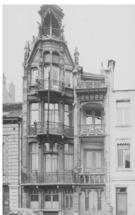
Photographie de la façade en 1976 (© CIVA).
