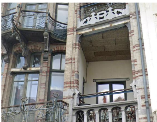
Etat actuel des loggias, baies modifiées et plafond en panneaux de fibre de bois (document extrait du dossier).
