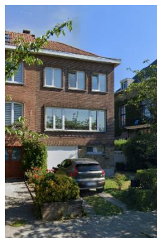
Façade avant (© Google Streetsview)
