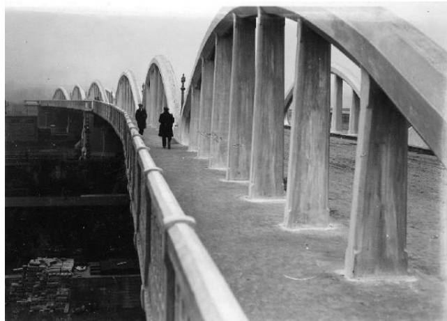
Pont en 1925, photo Jacques Hersleven (© KIK-IRPA cliché E023695). Le revêtement original de la chaussée et des trottoirs étaient probablement de type Macadam, composé de couches successives de pierres concassées de granulométries décroissantes, liées avec du sable et de l'eau, et agglomérées au moyen de rouleaux compresseurs.
