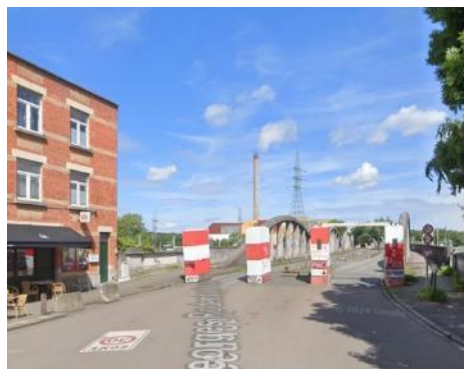
Dispositifs installés à l'accès vers le pont depuis l'avenue Zénobe Gramme (© Google Streetview)
