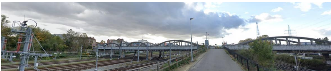
Vue sur le pont depuis Schaerbeek-Formation (© Google Streetview)
