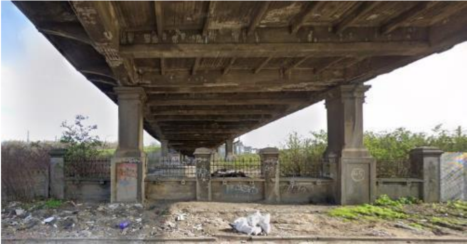
Structure portante et mur de clôture de l'avenue de Vilvorde après les travaux de décapage réalisés par Infrabel (© Google Streetview 2023)
