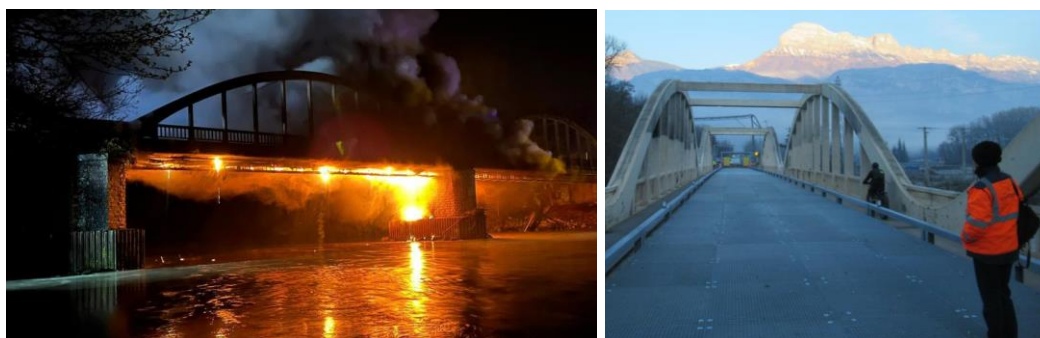
Pont de Brignoud : photo de l'incendie du 04/04/2022 et état en 2024, après restauration (© Quadric Groupe Artelia)
