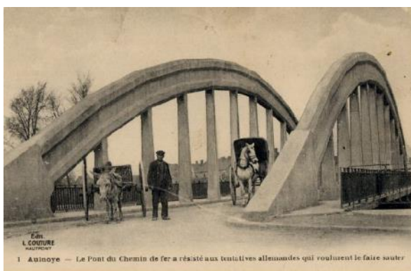
Pont d'Aulnoye-Aymeries (dépt. du Nord, France), 1913, réalisé par l'ingénieur français Albert Caquot
