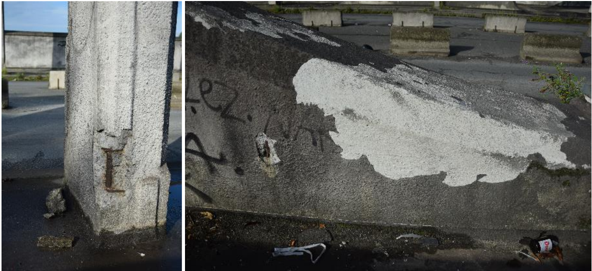
Structure portante et mur de clôture de l'avenue de Vilvorde après les travaux de décapage réalisés par Infrabel (© Google Streetview 2023)
