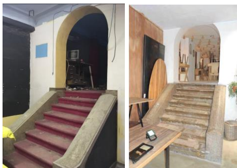
Vues de la baie au-dessus de la volée d'escalier menant à l'entresol. A droite, le faux-plafond masquant partiellement l'arcade (photos extraites du dossier)
