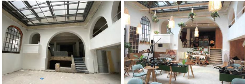
Vues de l'espace central en travaux/après aménagement (extraits du dossier)
