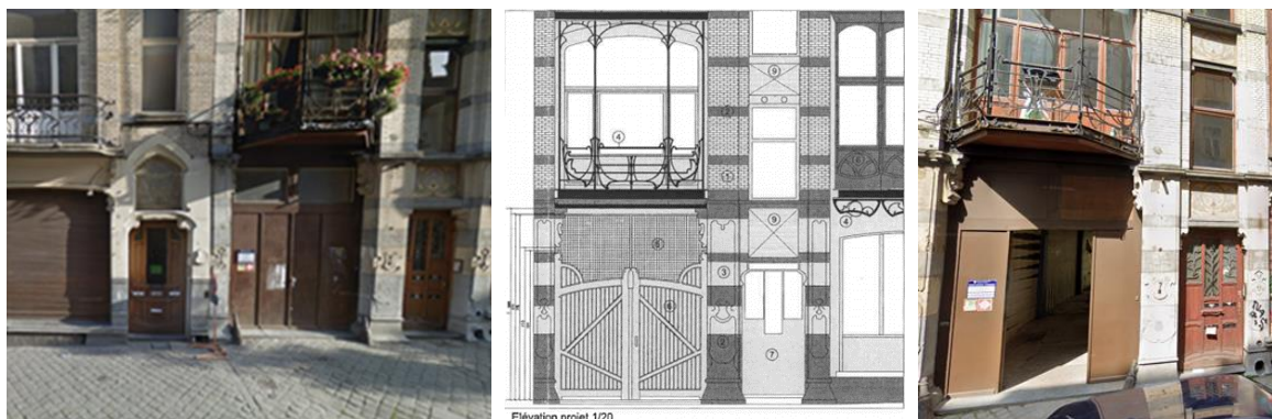
Vue avant 2014 : porte en bois avec imposte vitrée (extr. du dossier de demande), projet de 2015 (extr. du dossier de 2015), vue actuelle de la porte (©Google maps)
