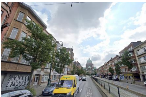
Perspective existante vers la basilique de Koekelberg depuis l'avenue Charles Quint © Google Street View
