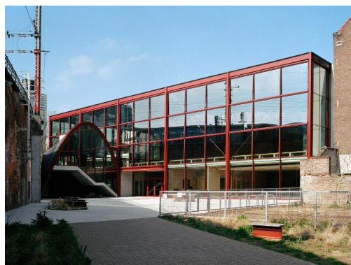
Photo de la situation existante extraite de la demande
