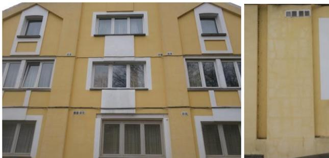
Façades côté Timon : châssis PVC et divisions inadaptées. L'appareil à faux-joints transparaît sous la finition actuelle (Photos CRMS, décembre 2024)
