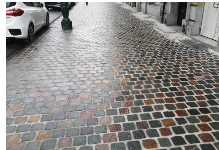
Matériaux : exemple de revêtements de trottoirs en pavés de porphyre. Photographie extraite de l'étude.
