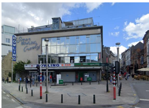
Façade avant du Bowling Crosly (© Google Streetview)
