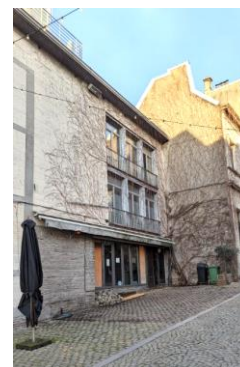
Façade n°2 rue de Rollebeek (photographie extraite du dossier)
