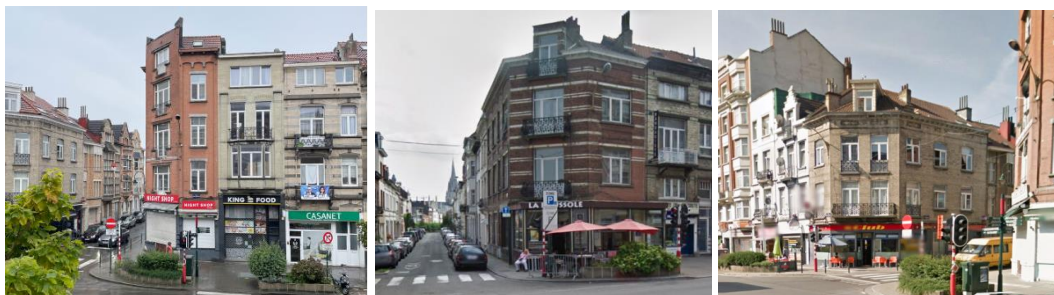
Vues des immeubles à appartements existants au carrefour du bd E. Bockstael / rue Bollen (© Google maps)
