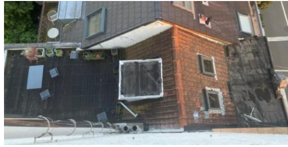
Photo aérienne de la toiture actuelle.
