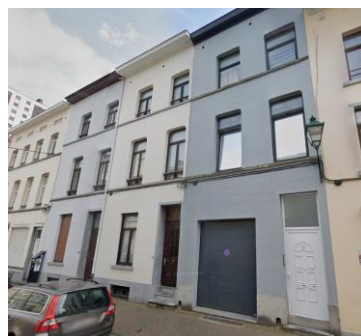
Vue des trois maisons en enfilade (© Google Streetview)
