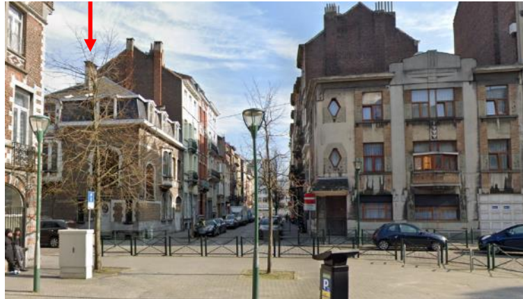
Inplanting van de woning Leclercq en de tegenoverliggende woning Roggen, rechts © Streetview
