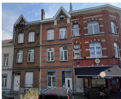
État existant des façades à rue © Google Streetview
