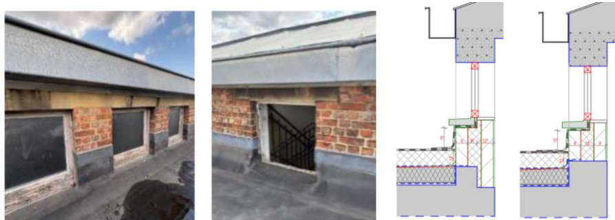
Photos des fenêtres et du portillon d'accès, suivi des détails projetés correspondants
