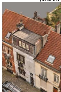
Vue des toitures du 118, rue Marconi et mitoyens (extrait du dossier)
