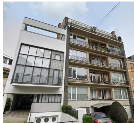
Vue de l'appartement concerné par la demande et du bien classé (© Google Street View)
