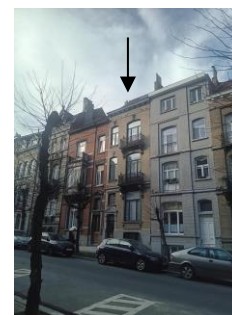
État de fait de la façade sur rue © Google Street View
