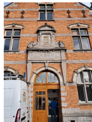
Bestaande toestand van de hoofdtoegang, foto uit het aanvraagdossier
